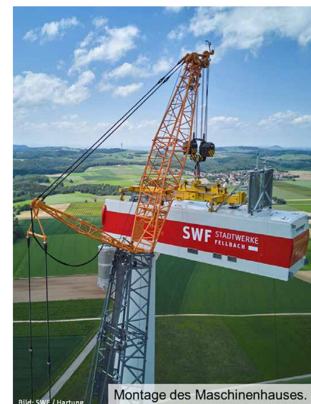
Der Stahlrohrturm ist fertig. Das Maschinenhaus wird gehoben.
