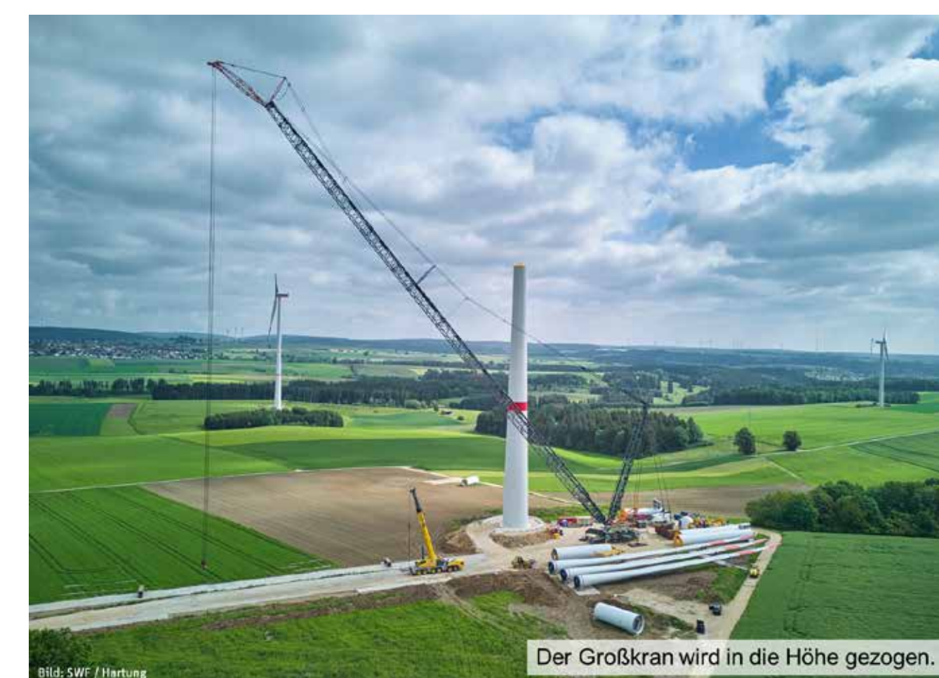
Aufbau des 90 m hohen Betonturms. Je Segment besteht dieser aus 3 zusammengesetzten 1/3 Schalen, hier links im Bild zu sehen.
