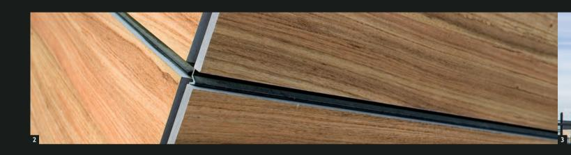
FISSAGGIO A SCOMPARSA MEDIANTE AGGANCIO SUL RETRO DELLE LASTRE SU SOTTOSTRUTTURA IN ALLUMINIO 🖊 (1)
